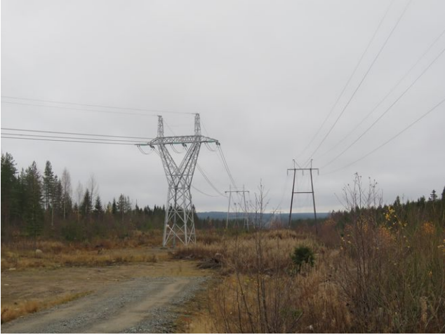
Kuva 21. Voimalinja hankealueen koillisreunalta koilliseen.
