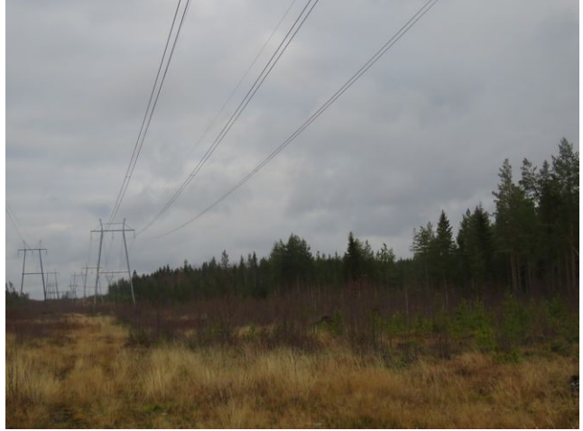
Kuva 22. Linja Tervosuon kohdalla, koilliseen.
